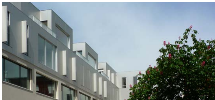
Figura 4: Les Marronniers (fonte: U15 Architectes)
